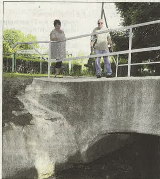
Die baureife Natursteinbrücke wurde mit Spritzbeton versehen. Foto: Peter Cissek
